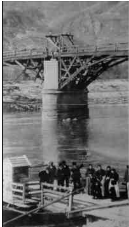
7 - Ultimi viaggi del tragheto con il ponte in costruzione.
