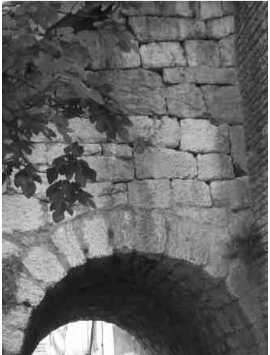
Ancor oggi è chiaramente visibile la sopraelevazione, più scura, della testa di ponte sinistra realizzata nel 1867-68
